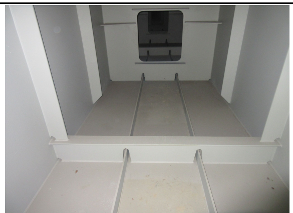
BOX 내부 시공 상태 점검
