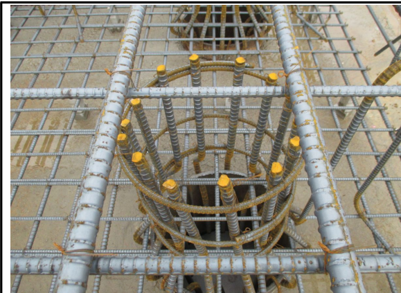
A2 기초 철근 시공 상태 양호 2015.06.02
