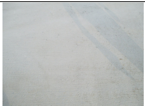
교면포장 상태 점검
