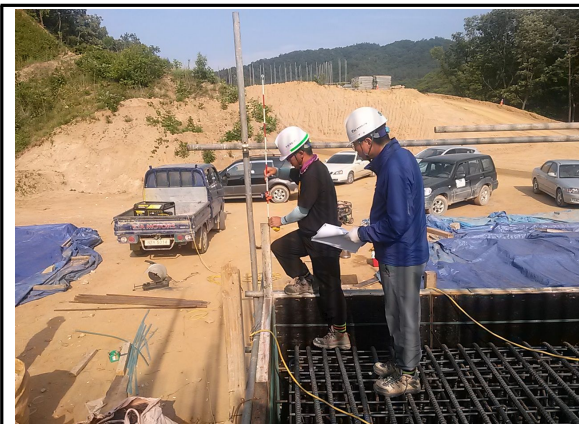
기초 철근 배근 간격 측정 2015.06.02
