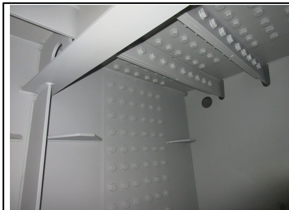
BOX 내부 시공 상태 점검
