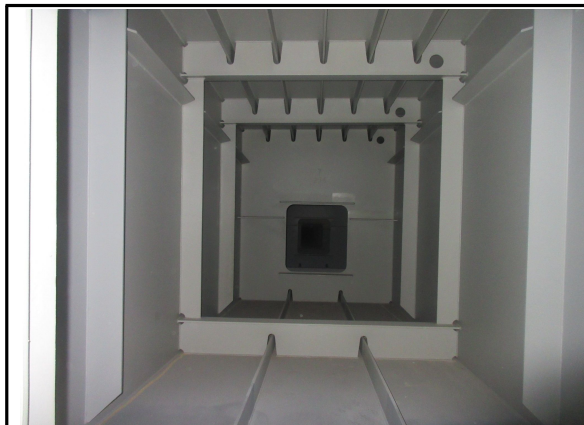
BOX 내부 시공 상태 점검
