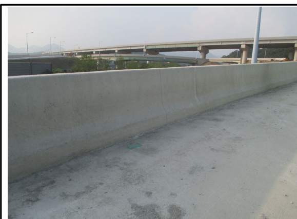
방호벽 시공 상태 점검
