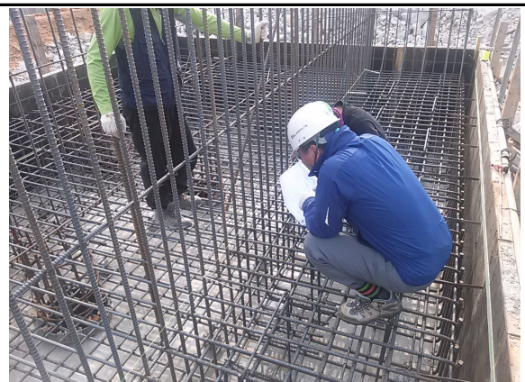
기초 철근 배근 간격 측정 2015.06.02
