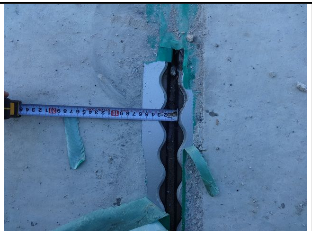
신축이음 A1 유간 측정
