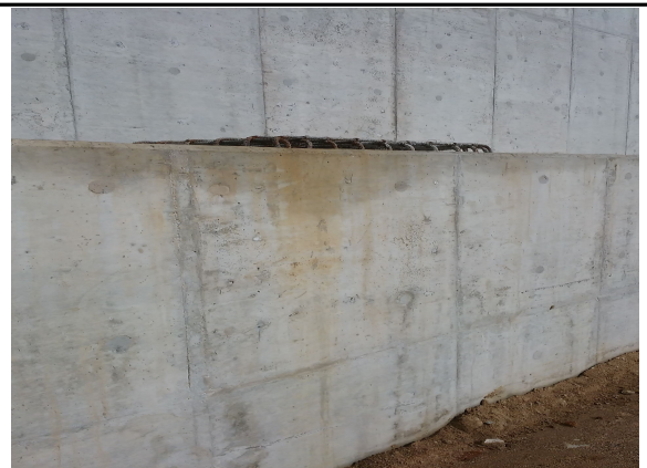
교대 A2 벽체 상태 점검(점검일:2015.11)
