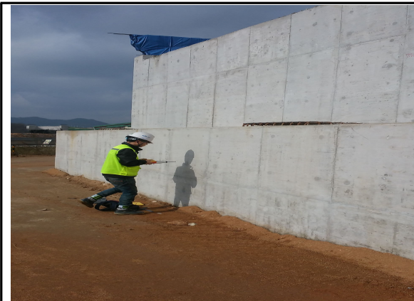
교대 A2 시공 전경(점검일:2015.11)
