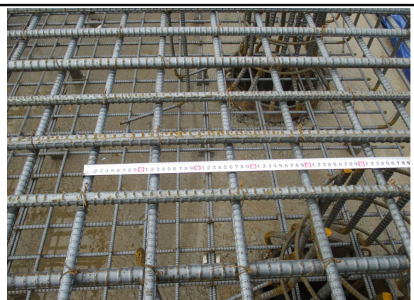
기초 철근 배근 간격 측정 2015.06.02
