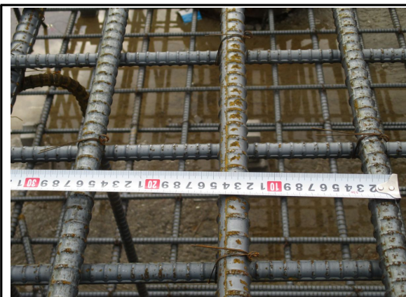
기초 철근 배근 간격 측정 2015.06.17
