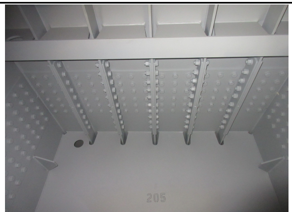
BOX 내부 시공 상태 점검
