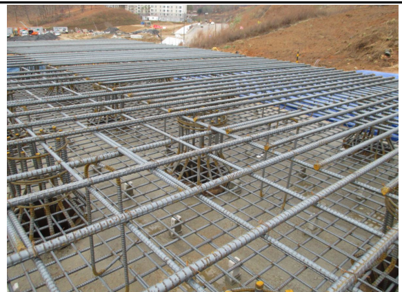
A2 기초 철근 시공 상태 양호 2015.06.02
